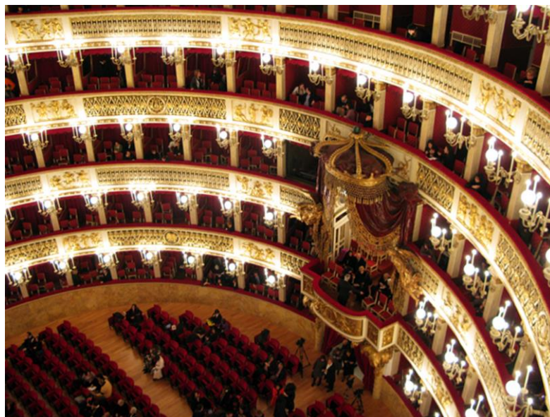
Figure II.9 : La réflexion diffuse générée par les colonnades, les statues et les fioritures dans une salle de concert à l'italienne (opera-online.com)
