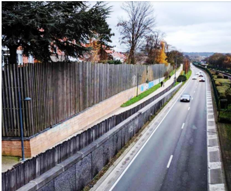
Figure II.27 : Les écrans antibruit absorbants (Bruxelles environnement, 2018)
