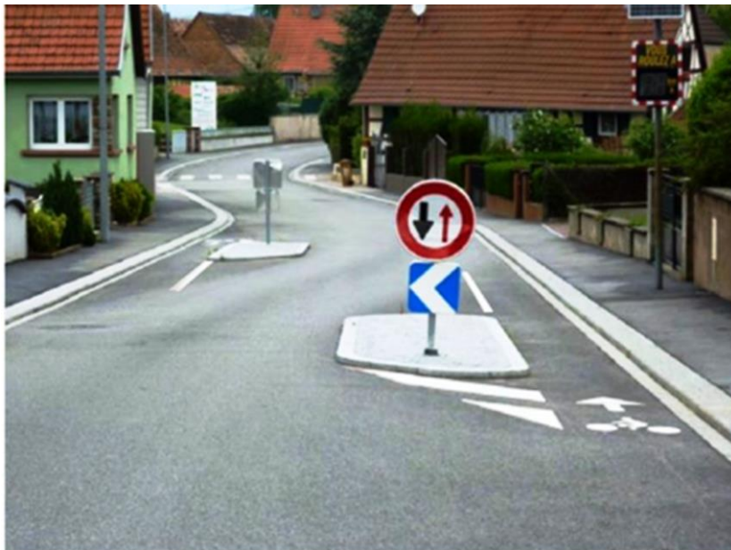
Figure II.25 : Le système de chicane dans les voies : un dispositif pour diminuer le bruit routier (Cerema, 2019)
