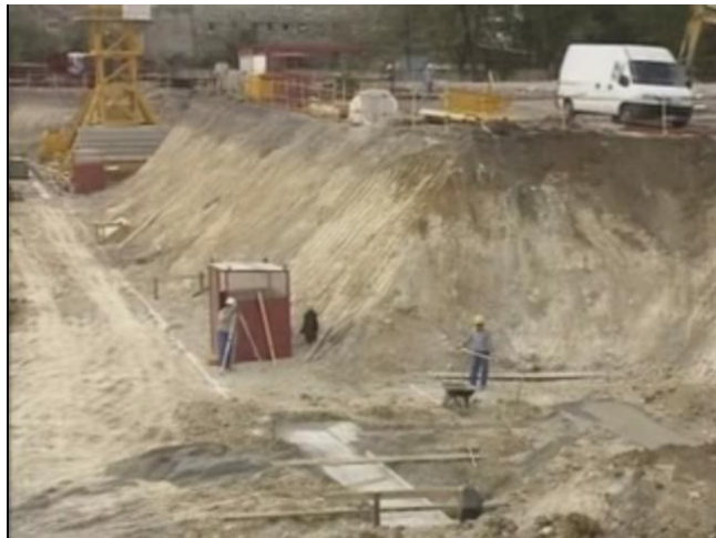
Figure III.1 terrassement en masse (19)
