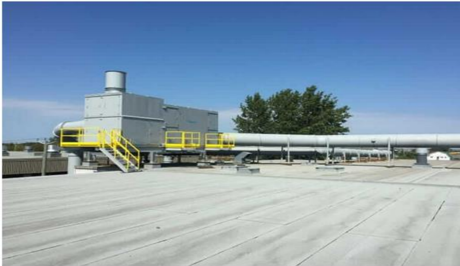
Figure VI.1 : Installation et disposition des échangeurs de chaleur
