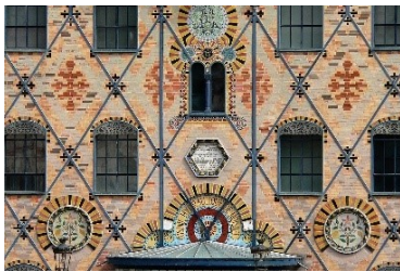
Figure LIX: L'armature métallique du moulin et Détail de la façade, montrant l'armature métallique exposée et les briques polychromes. Source : Wikipédia
