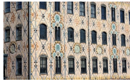
Figure LIX: L'armature métallique du moulin et Détail de la façade, montrant l'armature métallique exposée et les briques polychromes. Source : Wikipédia
