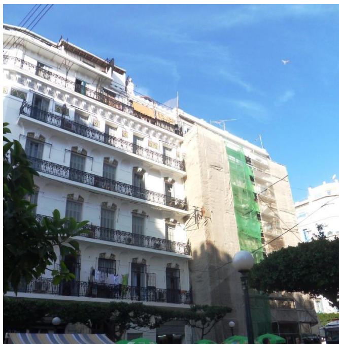
Fig. 50. Rénovation du vieux bâti colonial à Alger 71
